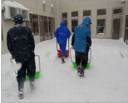
② 東和保育園避難路除雪作業
